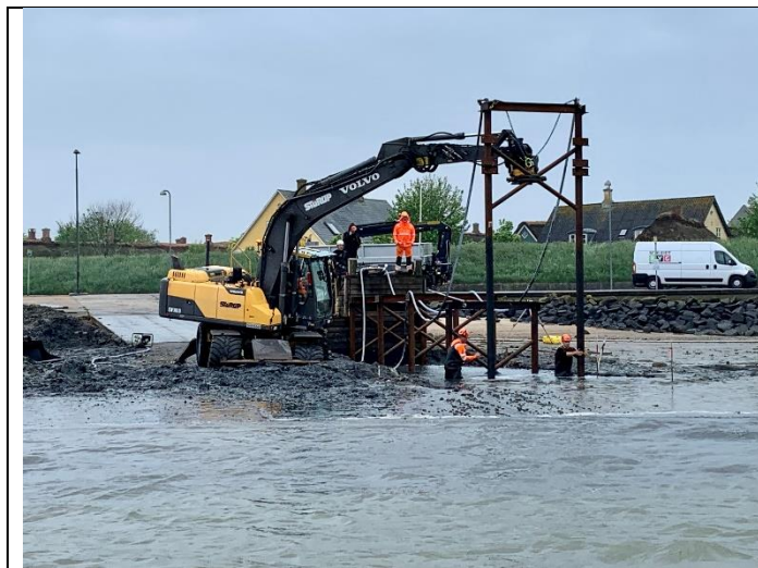
Rammerne til fundamentet nedspules.
